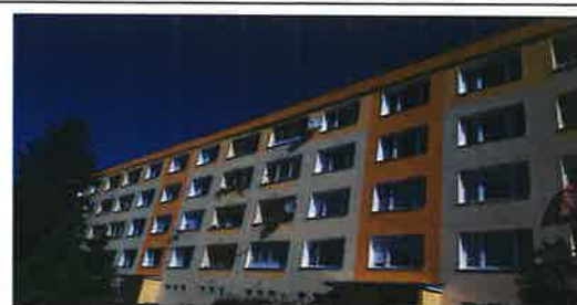
POLTÁR SKLÁRSKA UL., ZATEPLENIE OPLÁŠTENIA PANELOVÉHO DOMU, 2021
