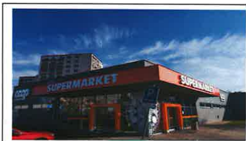
COOP JEDNOTA DETVA - REKONŠTRUKCIA FASÁDY, 2021
