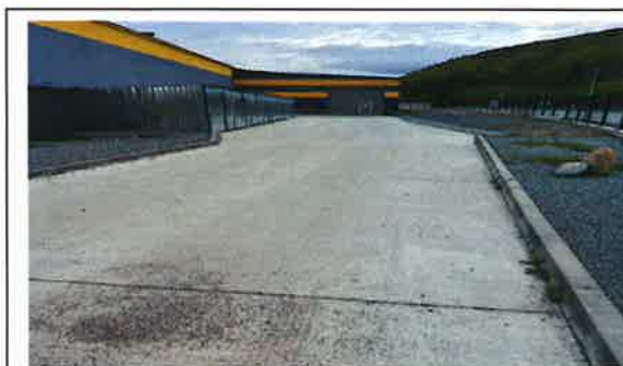
MICROSTEP HRIŇOVÁ BETONOVA PRISTUPOVA CESTA K HALE – VÝSTAVBA, 2019
