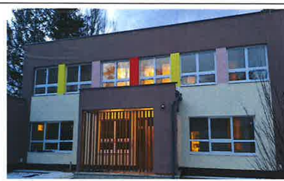
MŠ ZVOLEN PRACHATICKÁ – REKONŠTRUKCIA PAVILÓNU A, 2023
