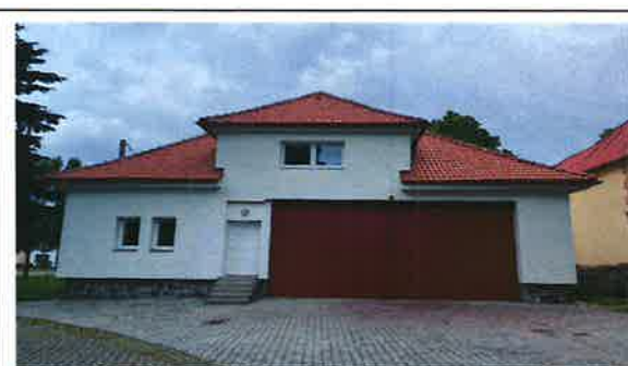
HASIČSKÁ ZBROJNICA DETVA - REKONŠTRUKCIA A MODERNIZÁCIA, 2020
