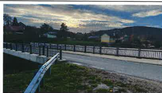
VÝSTAVBA NOVÉHO MOSTA, ČIERNY BALOG - KRÁM, 2018
