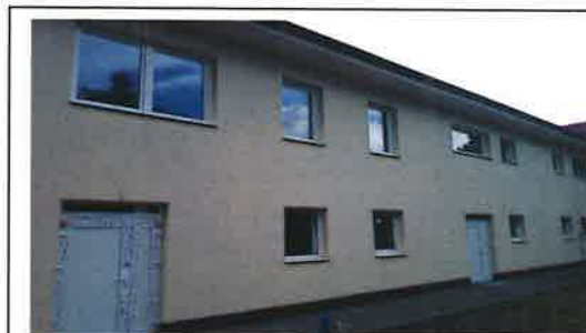
OBNOVA KOMUNITNÉHO CENTRA, DETVA, 2020
