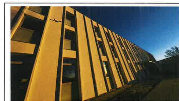
SPOJENÁ ŠKOLA DETVA – MODERNIZÁCIA DIELNÍ ZATEPLENIE A VNÚT. REKONŠTRUKCIA, 2023
