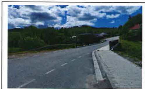
VÝSTAVBA NOVÉHO MOSTA, ČIERNY BALOG - KRÁM, 2018
